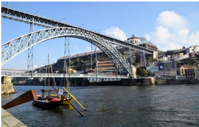
Figura 1: Ponte D. Luís, Porto. Créditos: Korido, Wikimedia Commons
