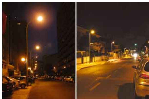
Fig. 3 - Duas ruas diferentemente iluminadas. Na fotografia da esquerda, os candeeiros (dos tipos 3 e 4 da figura anterior) emitem bastante luz para os lados e para cima. Na imagem da direita, os candeeiros (do tipo 2 da foto anterior), são mais direccionados para baixo. O solo desta rua tem muito melhor iluminação.
