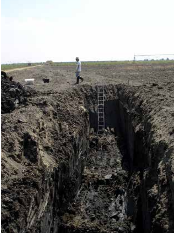
Fig. 3 – Imagem de uma das trincheiras abertas sobre a Falha de Vila Franca de Xira.
