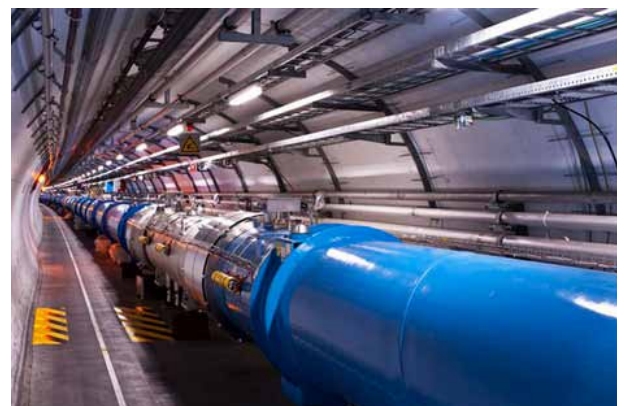
Fig. 1 - uma pequena parte do túnel do LHC onde se veem ímanes supercondutores dipolares que conduzem a órbita dos feixes, a azul, e ímanes quadripolares, a branco, que focam os feixes. (imagem: CERN Genebra)
