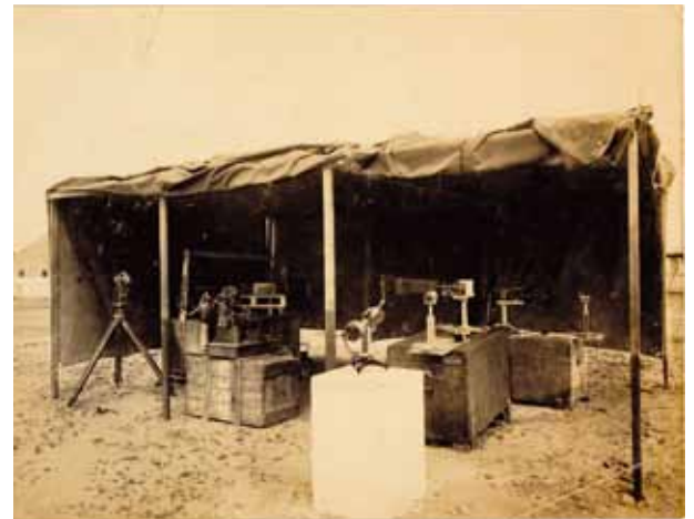
Figura 9 - Espectrógrafos instalados em Sobral. Cortesia do Museu de Astronomia e Ciências Afins, Rio de Janeiro.
