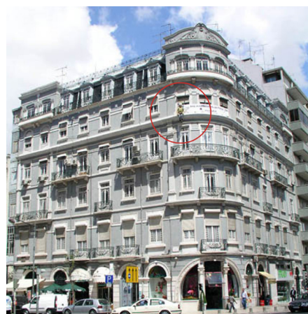
Figura 1 - Edifício da 1ª sede da SPF (4.º andar), partilhado, a partir de 1976, com a SPQ e a SPM, a que se juntou, em 1978, a Sociedade Portuguesa de Filosofia. A fotografia, feita em 2005, tem o pormenor de celebrar o ano internacional da Física, assinalado com a figura de Einstein colocado nas janelas de esquina do prédio.
