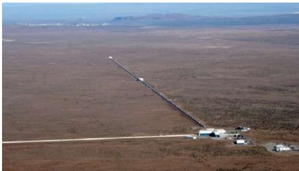
Figura 8 - Vista do observatório LIGO em Hanford, estado de Washington. Os dois braços de 4 km cada, formando um L, são claros.
