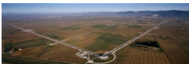
Figura 10 - Observatório Virgo em Santo Stefano a Macerata, perto de Pisa, Itália. Faz parte do Observatório Gravitacional Europeu. Por cima de cada braço de 3 km foram construídos viadutos para passagem de veículos das quintas vizinhas.
