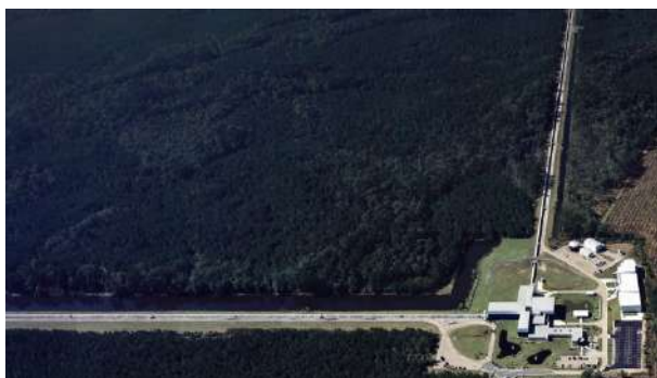
Figura 9 - Vista parcial do observatório LIGO em Livingston, estado da Louisiana.
