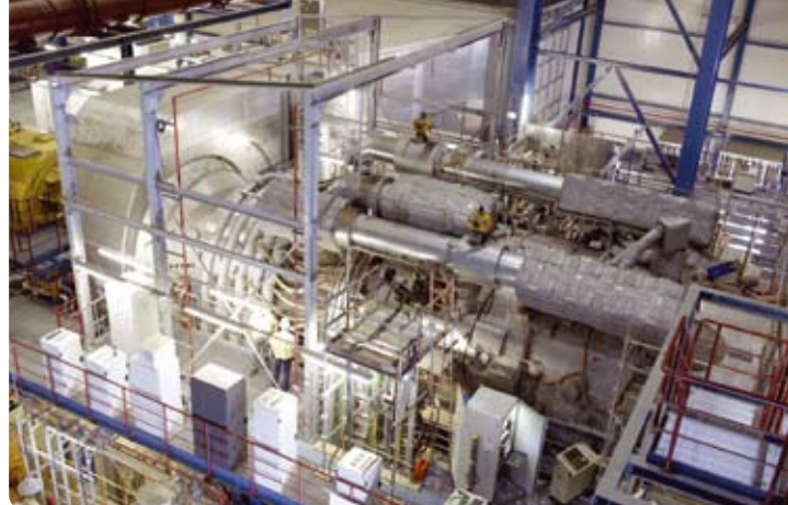
Turbina a gás de ciclo combinado do tipo das que estão a ser instaladas na Central do Pego em Abrantes (cortesia da Siemens).
