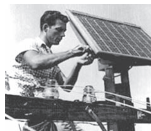
Fig. 4 - A primeira aplicação de uma célula solar de silício foi como fonte de alimentação de uma rede telefónica local em Americus, na Geórgia, Estados Unidos da América, em 1955.
