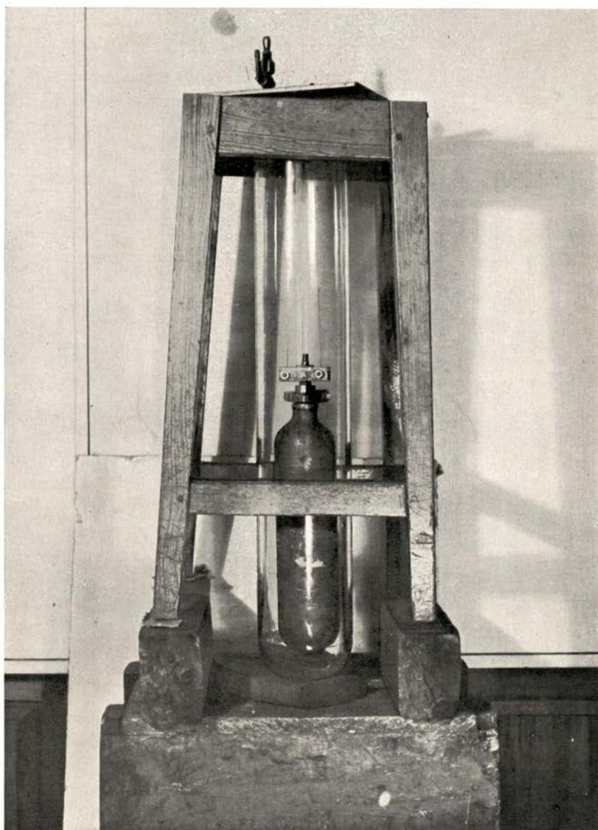
Fig. 2 — Viscosimètre à cylindre oscillant.
